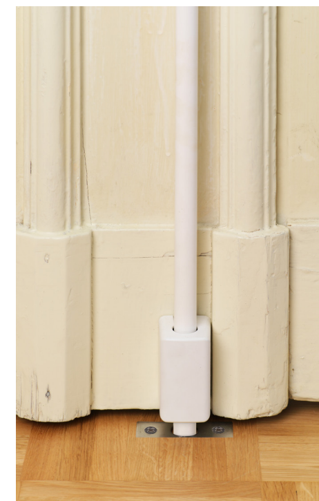
detail upevnění do podlahy
