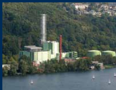
Plynová elektrárna, Herdecke, Německo
