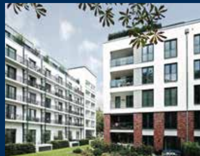
Bytový dům, Hamburk, Německo
