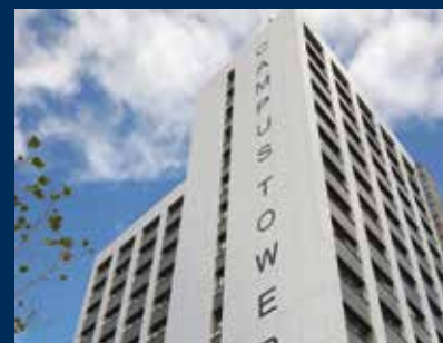
Hostel Campus Tower Magdeburg, Německo
