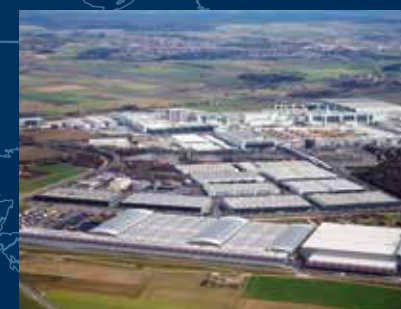
Freight Village Ingolstadt, Německo
